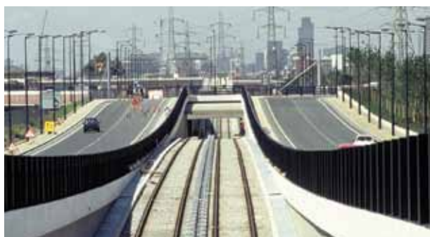
Bygging av motorvei parallelt med eksisterende jernbane.
