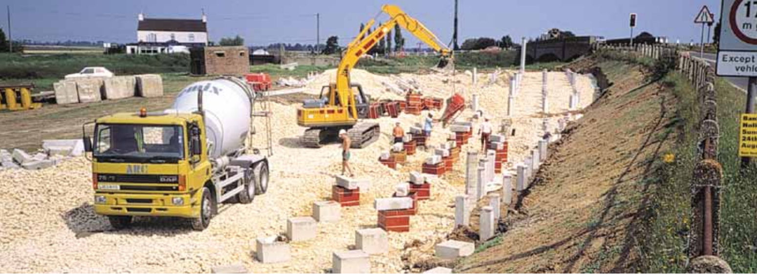
Små pelehoder støpes før bygging av TensorTech Plateau lastfordelingsplattform.
