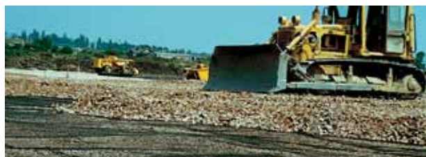
Dimensjonert lagtykkelse legges ut og komprimeres.
