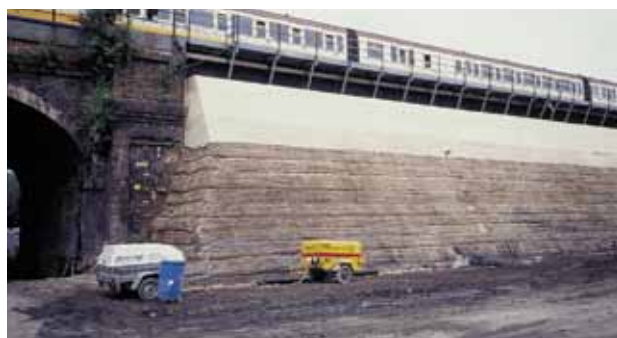
Forsterket veifylling over peler med bruk av Tensar Basetex.
