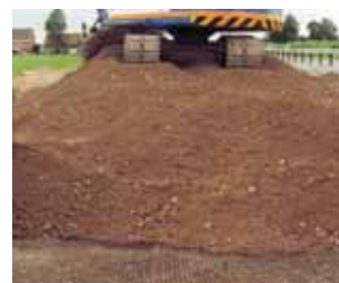
Utlegging av fylling.
