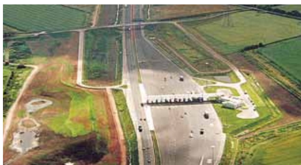
Motorvei med bomstasjon bygget på TensarTech Plateau LTP - valgt alternativ for å unngå forbelastning med uforutsigbart setningsforløp.
