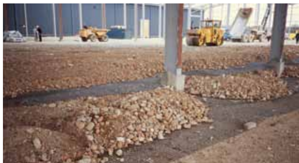
Bygging av kjøpesenter med TensarTech Plateau LTP som er en utprøvd og pålitelig løsning.
