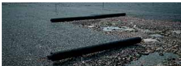
Et lag med Tensor geonett legges ut.
