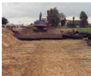
Utlegging av geonett.
