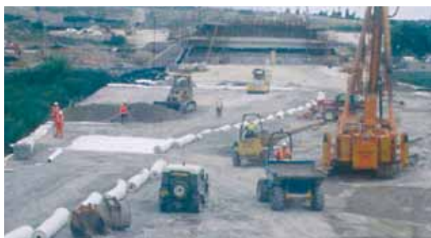
Tensar Basetex oppspent duk under høyhastighets jernbanefylling.
