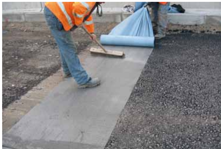
GlasstexPatch 880 kan monteres på de fleste underlag ved effekten av klebebelegget, og kan ligge litt under trafikk.
