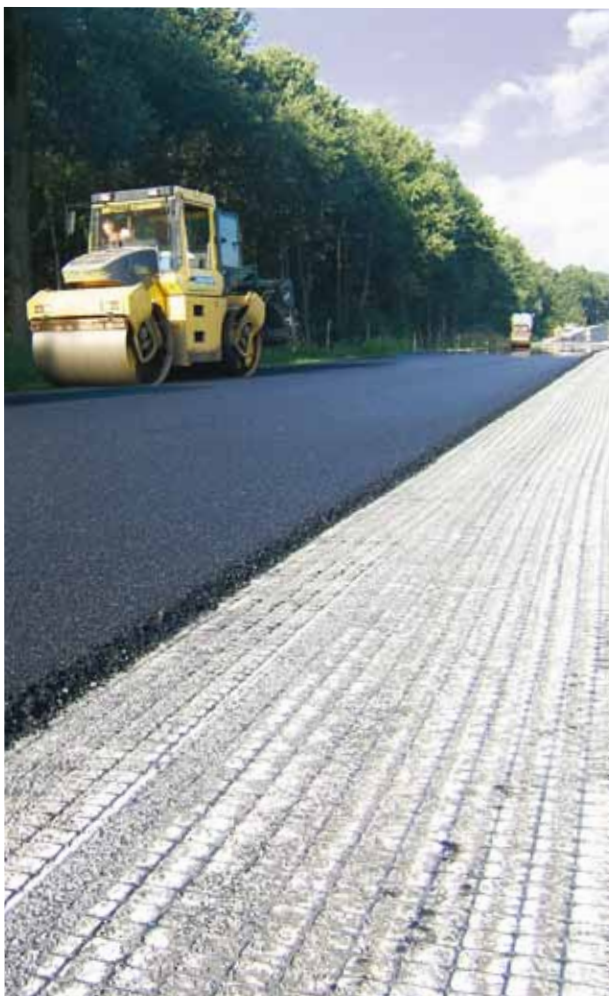
Tensar AR-GN hefter godt til underlaget slik at det tillater asfaltering direkte på nettet.
