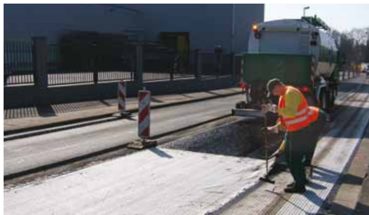
En enkel overlapp for Tensar Glasstex. Se installasjons rettledningen.
