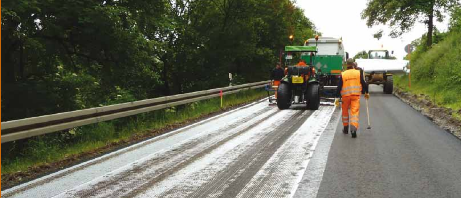
Installasjon av GlasstexGrid RN er likefrem.
