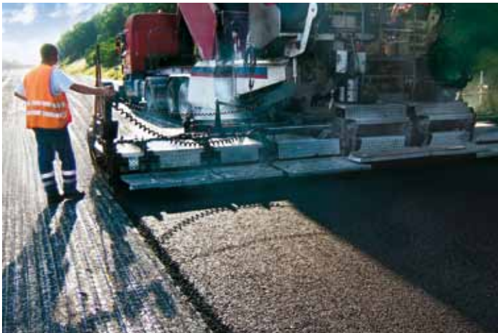
Asfaltering kan skje direkte på Tensar AR-GN.
