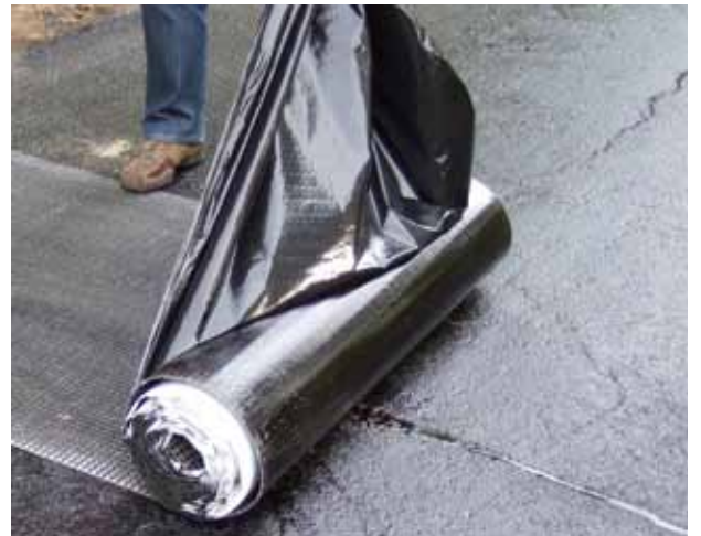
GlasstexPatch 880 kan installeres hvor det er behov for å kontrollere refleksjonssprekker og utmattingsspreker.
