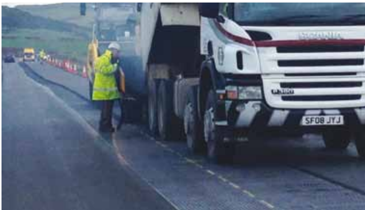
Tensar AR-GN gir utmattingmotstand og begrenser brudd på grunn av langtidseffekten av begrenset sideveis forskyning i underlaget.
