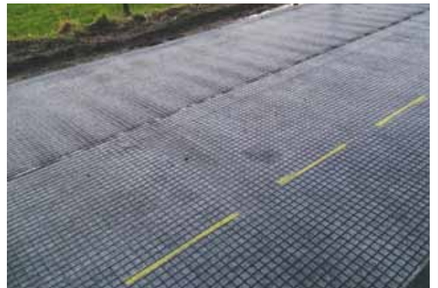
Tensar AR-GN gir utmattingmotstand og begrenser brudd på grunn av langtidseffekten av begrenset sideveis forskyning i underlaget.
