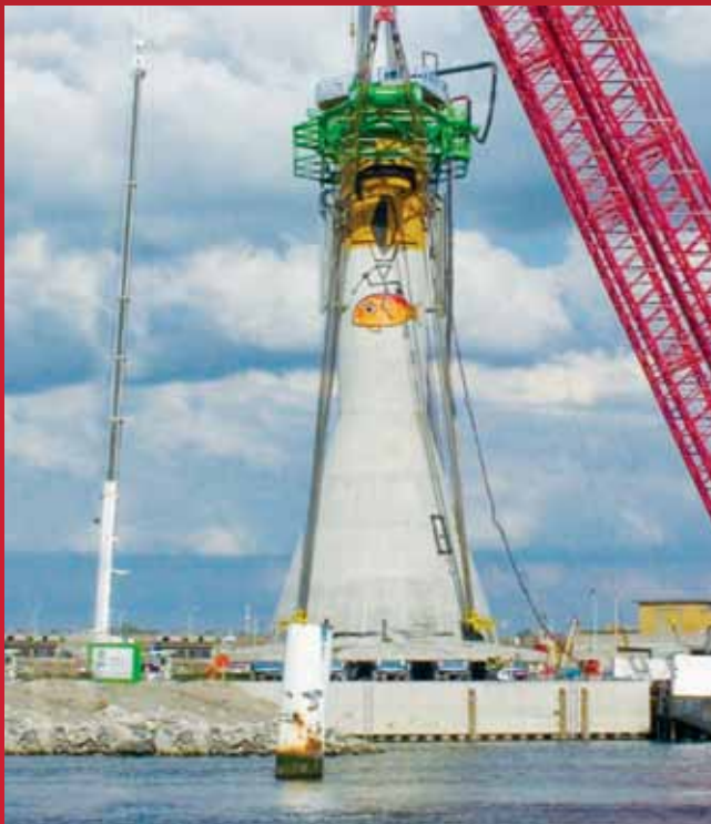
Stabile monteringsplattformer er nødvendig for konstruksjon av offshore vindparker. (Foto: Luc Van Braekel).
