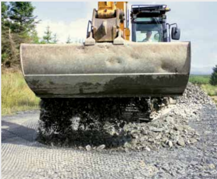
Adkomstveier under konstruksjon i Arecleoch, Scotland.
