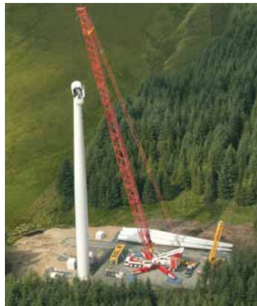
Montering av en turbin ved bruk av en mobilkran på en Tensar forsterket arbeidsplattform på Hadyard Hill, Scotland.
