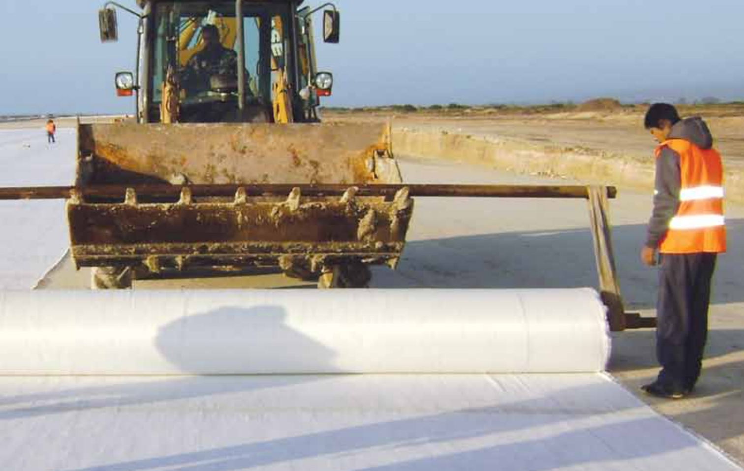
Utlegging av Basetex på flyplassen Oran i Algerie gir permanent stabilitet til overliggende forsterkningslag med en rask og kostnadseffektiv installasjon.
