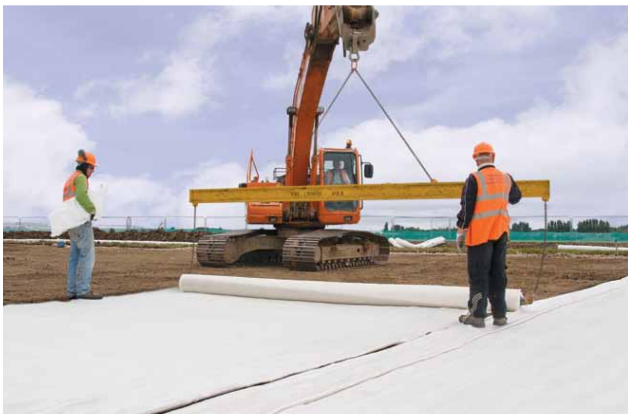
En standard størrelse på en rull med Basetex er 4,4m bred x 100m lang, noe som muliggjør rask installasjon.
