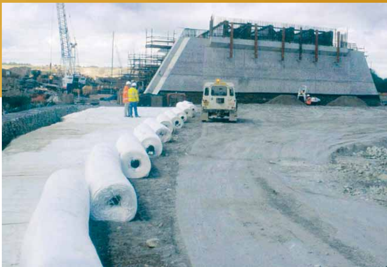
Tensar Basetex som oppspent membran forsterker en fylling for en høyhastighetsbane.
