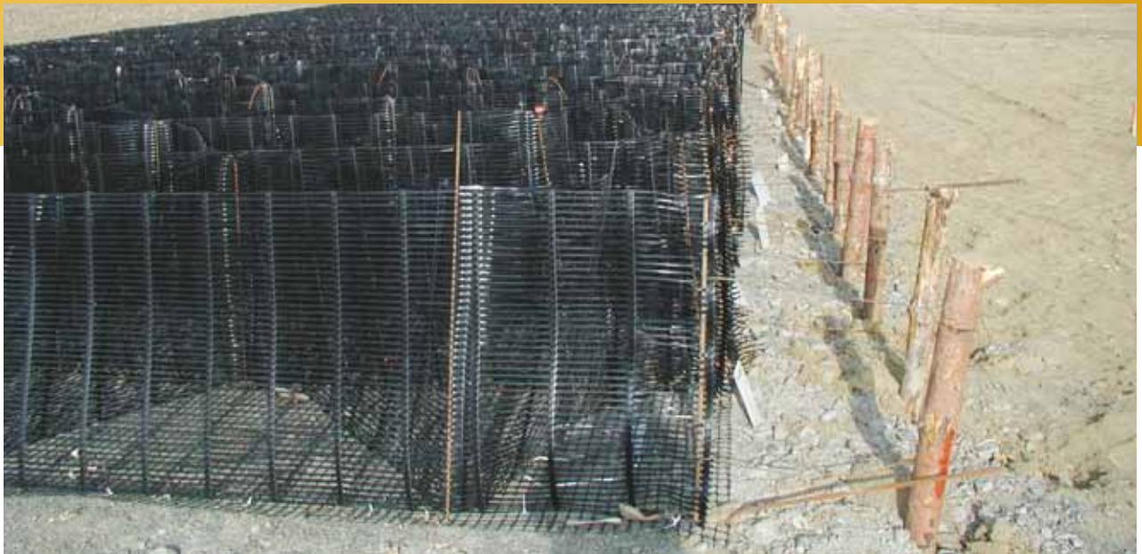
2. Rask montering av TensarTech® Stratum® Systemet.
