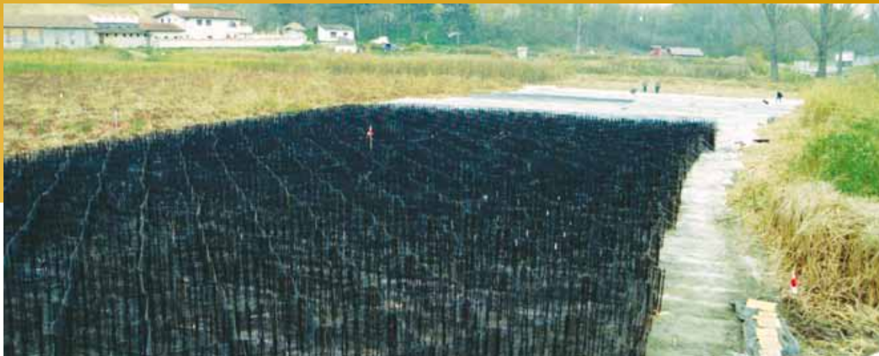
Utprøvd anvendelse av TensarTech® Stratum® Systemet for å stabilisere og drenere grunnen under en fylling (Kasposmero, Ungarn).
