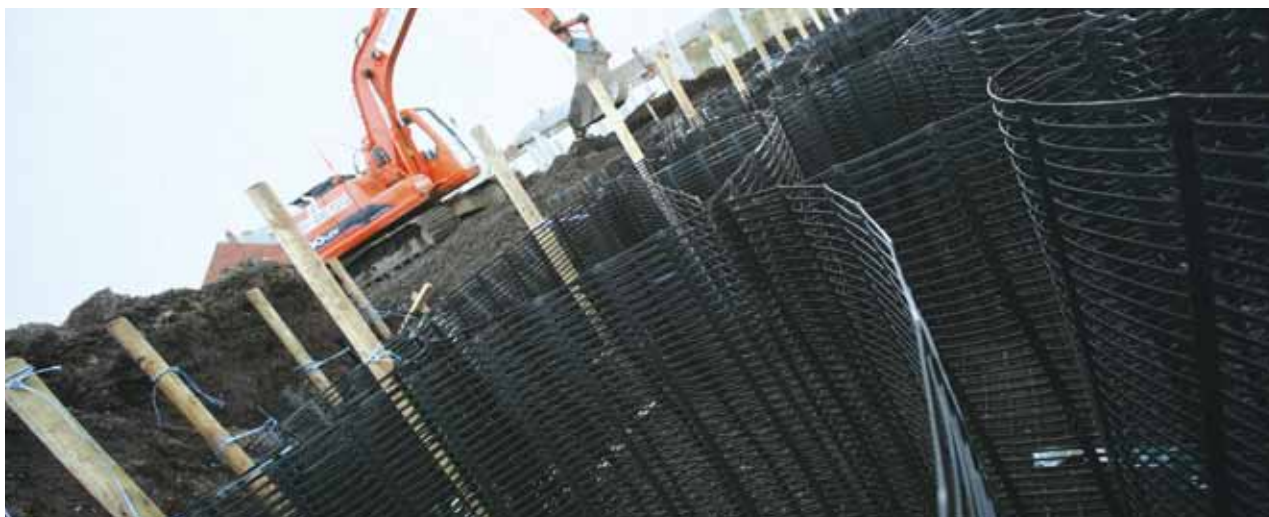
Utprøvd anvendelse av TensarTech® Stratum® Systemet for bygging av atkomstveg over veldig bløt grunn med høyt grunnvannspeil (Northcumberland, UK).
