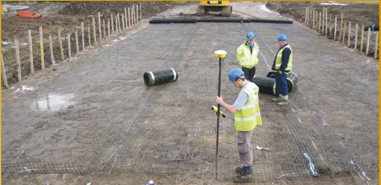
1. Basen til geocellesystemet bestående av geonett, rulles raskt ut på underlaget.
