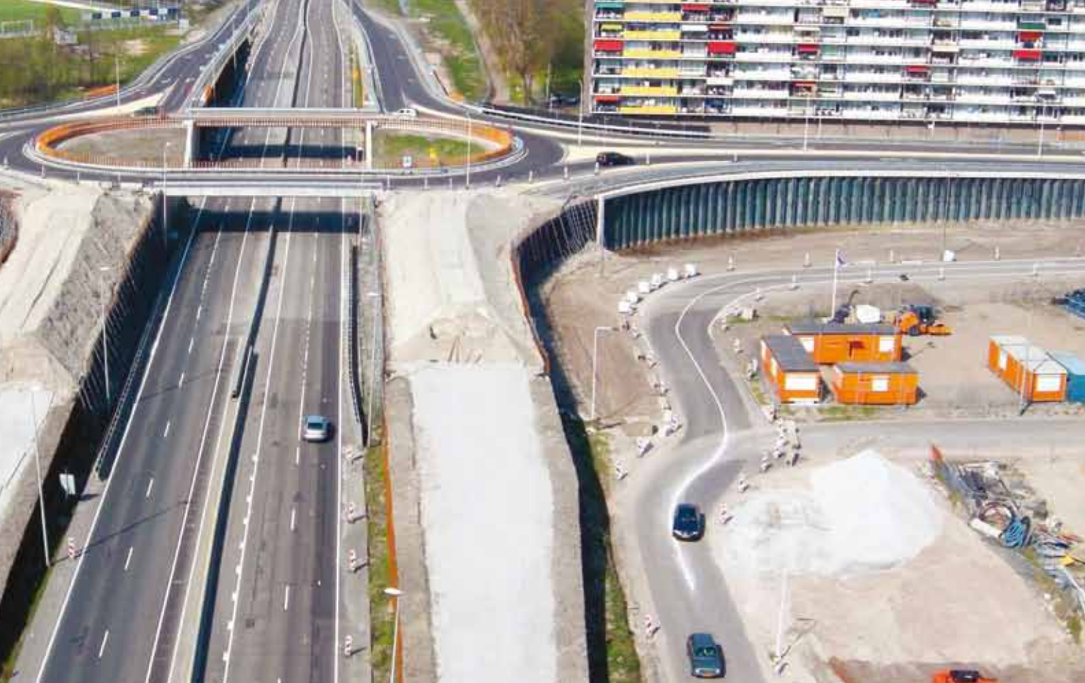
TensarTech® Stratum® Geocellesystemet gir et stivt underlag som bidrar til å få kontroll over skjevsetninger (A7 motorvei, Nederland).
