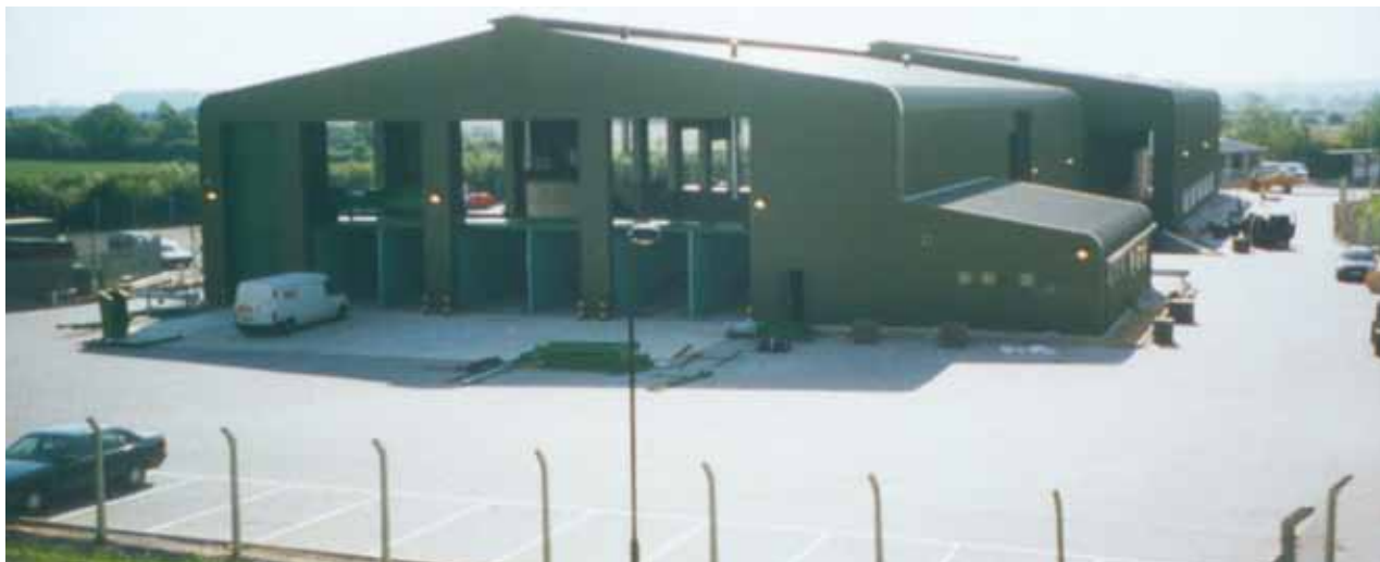
Utprøvd anvendelse av TensarTech® Stratum® Systemet for å ha kontroll med differensialsetninger i underliggende fyllmasser ved oppføring av bygg (Elstow, UK).
