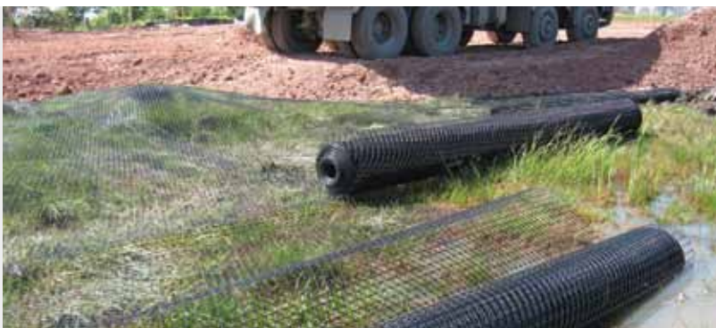
Grunnforsterkning og stabilisering, Lanarkshire
