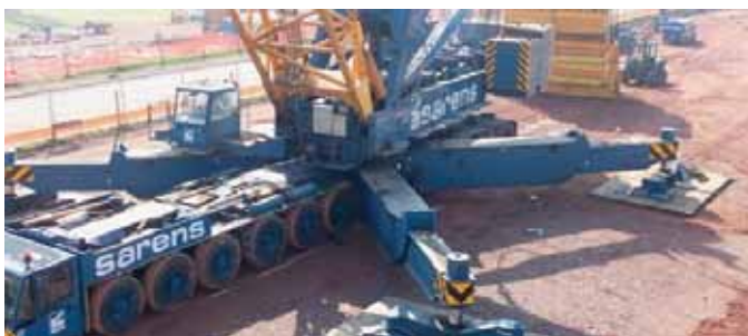
Tung mobilkran på Tensarstabilisert arbeidsplattform
