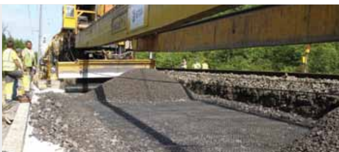
Fordeler til Tensar grunnstabilisering for jernbane
