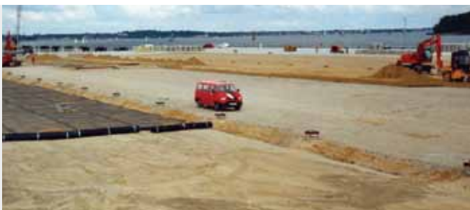
Tensar geonett er perfekt for konstruksjoner på havneområder (Latvia)
